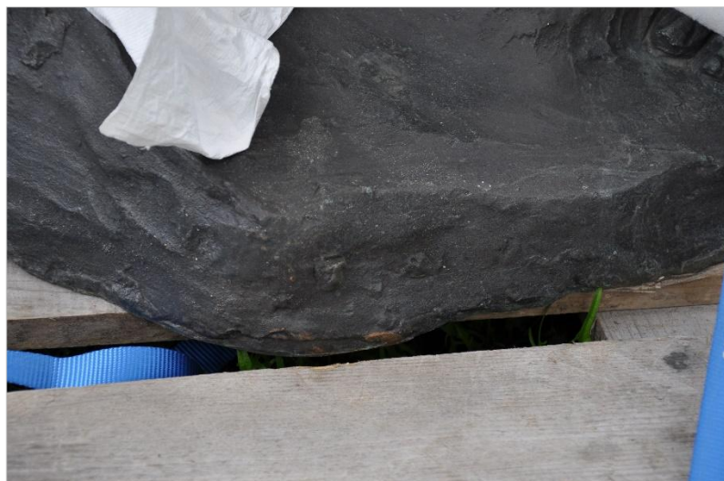
Bilde 24: Detalj av skade på plinten.
