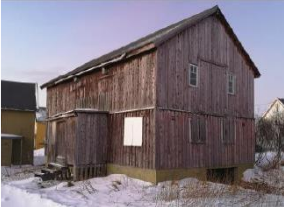
Utvendig bilde av bygningen:
