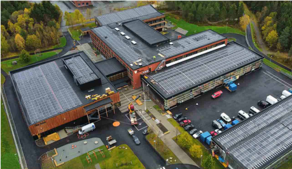
Tiller videregående skole har 3,2 mål med solceller på taket og 16 gjenbrukte elbilbatterier i kjelleren. Det blir det bærekraftig strøm av. Foto: Fjeldseth AS
