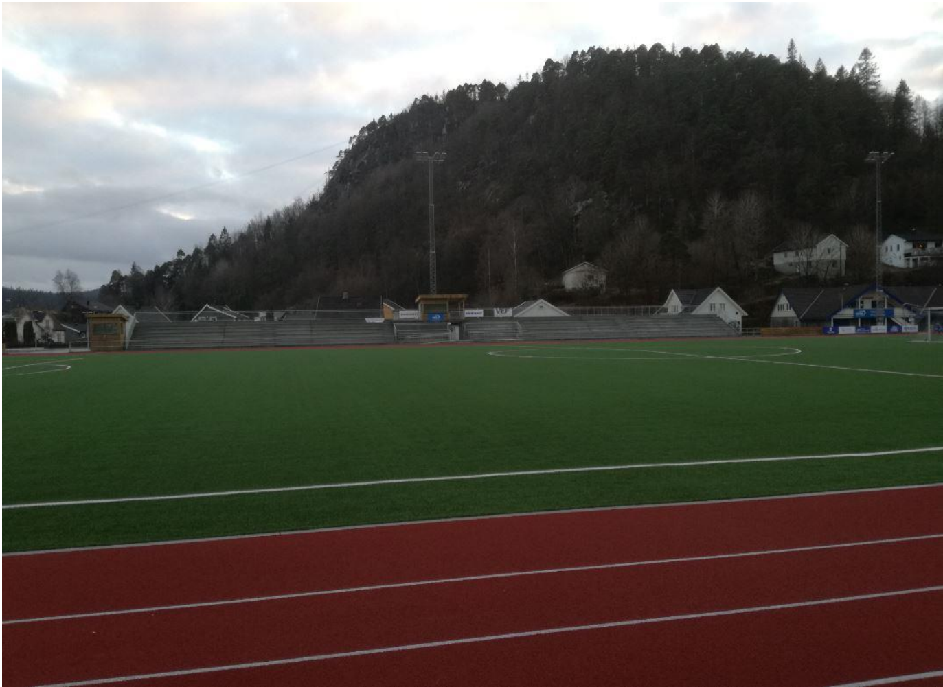
Figur 44, Ferdig bygget ny friidrettsbane, fotballbane og tribune, «o_BSS1», sett mot sør. Foto ViaNova Kristiansand AS
