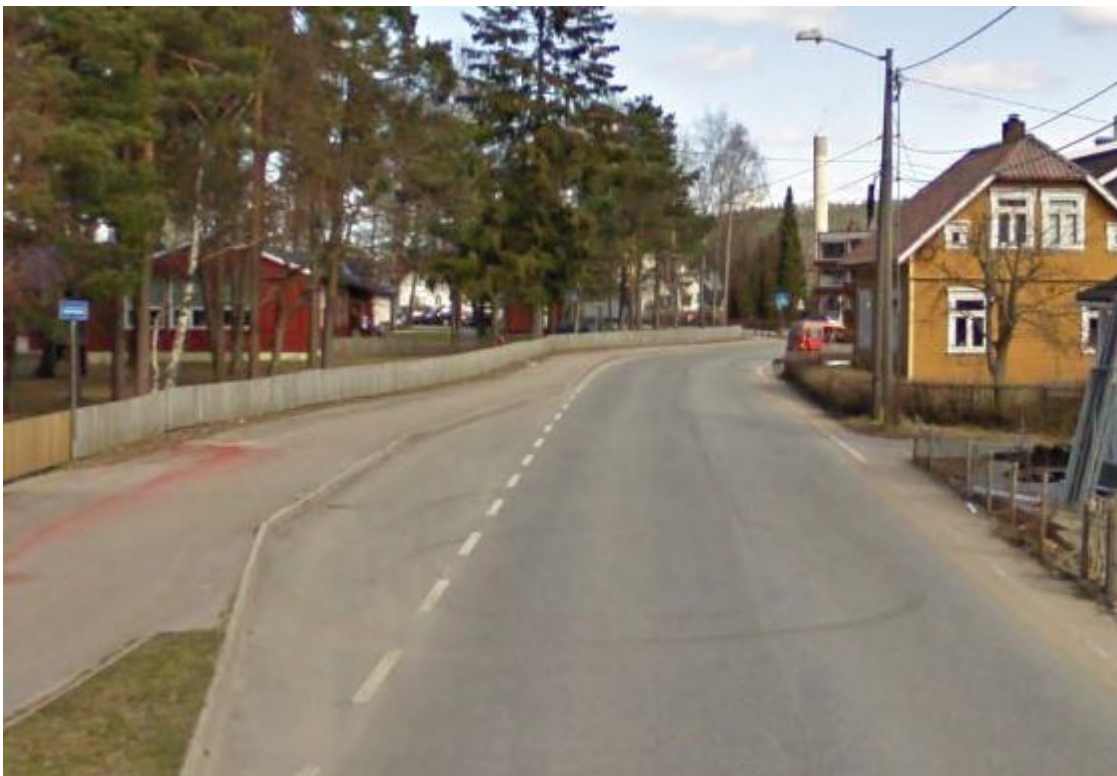
Figur 19, Eksisterende bussholdeplasser langs Ravnåsvegen, sørover. Foto Google maps
