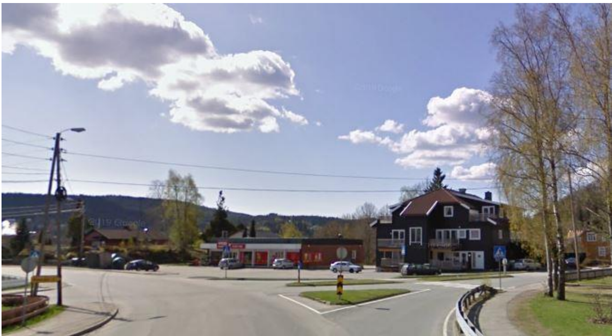
Figur 14, Eksisterende kryss Drivenesvegen-Ravnåsvegen. Foto Google maps
