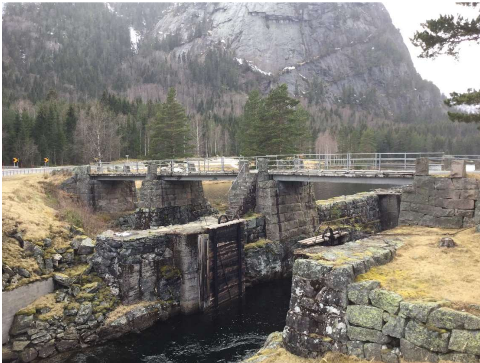
Figur 22. Slusebrua sett fra nord. Foto: SVV, 2019
