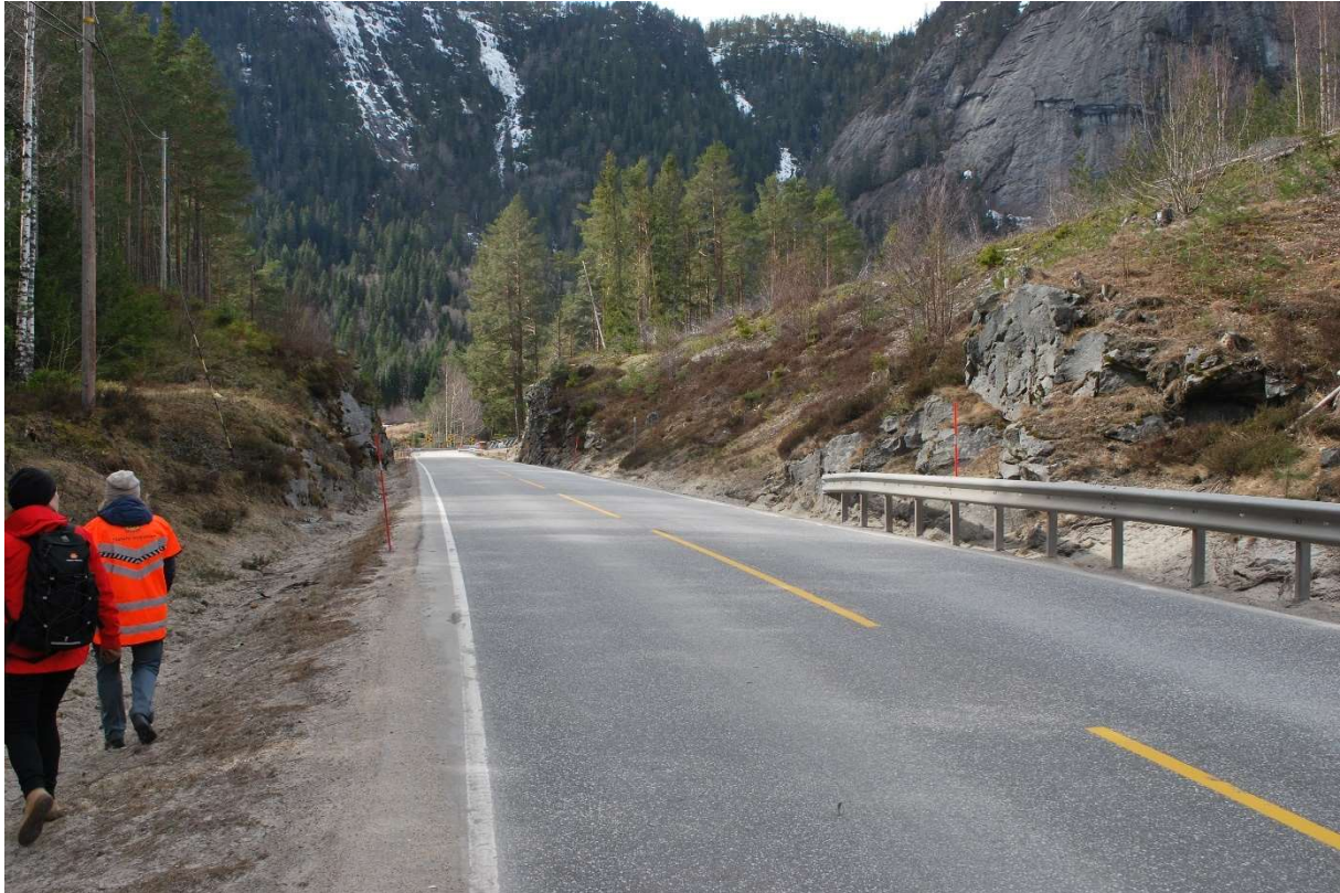
Figur 25. På bildet ser man mot det fredede brumiljøet. Man vil gå relativt tungt inn i vegskjæringene på begge sider av vegen her. Foto: Marit Anita Skrede, SVV 2022
