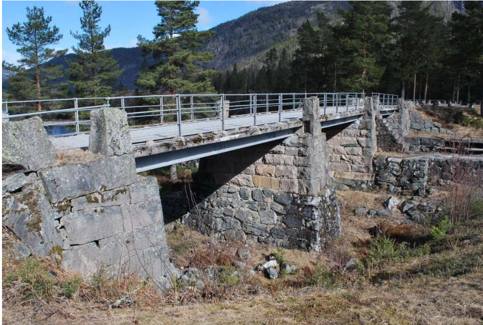
Figur 21. Slusebrua sett fra sørsida. Foto: Marit Anita Skrede, SVV 2022.
