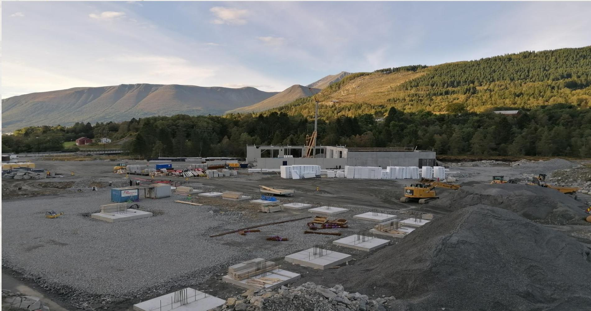
Stripefundament papirhall til venstre. Fundament for garderobes/driftskontor i midten. Montering av vegg mellom vaske- og lastehall til h.
