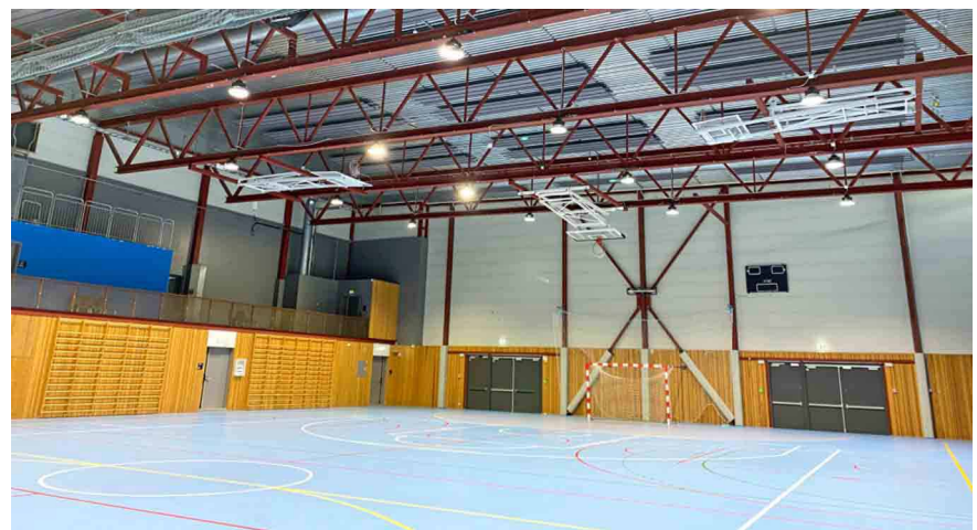
Apalløkkå flerbrukshall. Foto: I. Bergfjord, Norsk Energi
