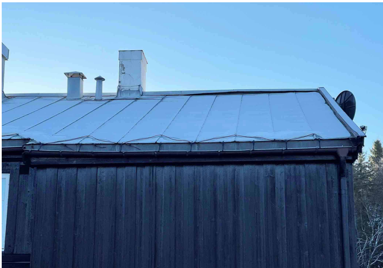
På Lysebu Hotel i Oslo har de begynt å montere varmekabler ytterst på takene. Foto: Lysebu Hotel
