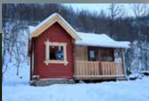
Fjørtofthytta er ferdig restaurert
