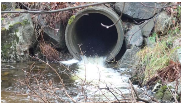
Bilde 69 og 70 (1919-20) Linanebekken munner ut i et sement røyr som går under en lokalvei mot eneboliger ved elva. Oppgangsforhold for eventuell fisk er ikke gode.
