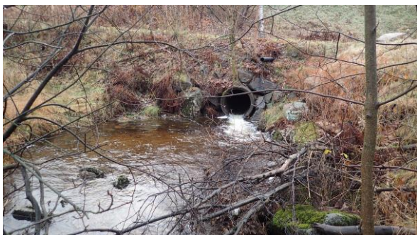
Bilde 69 og 70 (1919-20) Linanebekken munner ut i et sement røyr som går under en lokalvei mot eneboliger ved elva. Oppgangsforhold for eventuell fisk er ikke gode.
