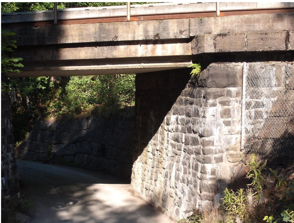
Figur 22 Eksisterende jernbaneundergang på Lianevegen.
