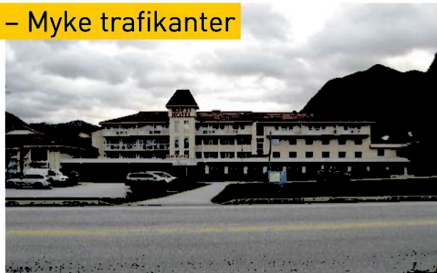
Hvor er fotgjengerovergangen?
