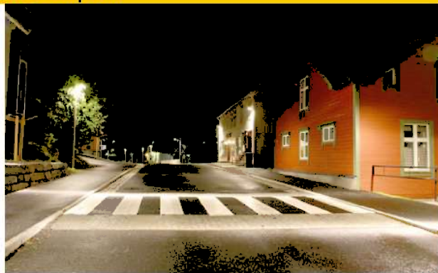
Belysning på opphøyet gangfelt, miljøgata i Tingvoll
