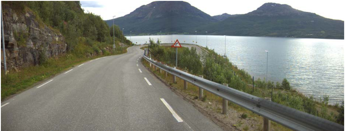
Bilde 10: Sørvik mot Ibestadtunnelen (NVDB)
