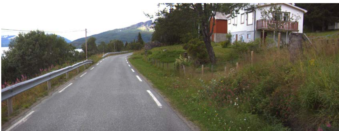
Bilde 6: Dagens veg ved bygda Eineberget (NVDB)
