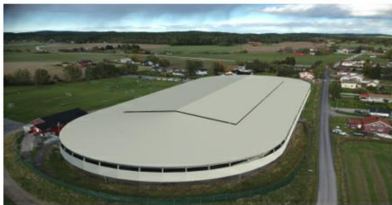
Byggetrinn 2: Videreføring av takoverbygget i trinn 1 med tak over midtre bane for å lage et "lukket system" samt fornyelse av banens fasilitetsbygg med eventuelt hockeybane i midtre del.
