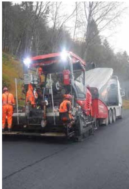
Rykande fersk asfalt vert lagt på fv. 60 Ugle-Skarstein. Veganleggget er planlagt opna for trafikk 1. mars 2018. Foto Statens vegvesen.
