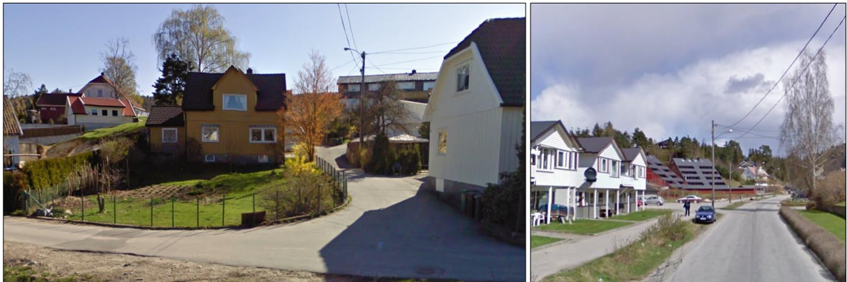
Figur 21 Bildet til venstre viser boligområdet ved Revia, og bildet til høyre viser eksempel på mer konsentrert bebyggelse nordvest i planområdet. (Kilde: Google maps)
