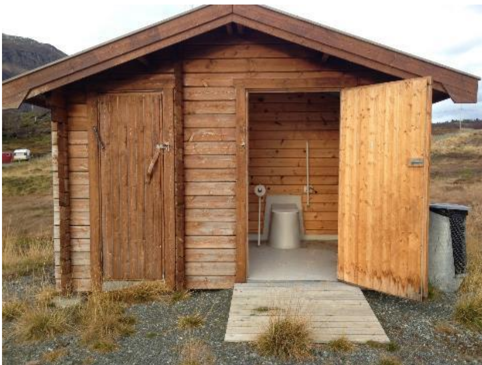
Figur 10. Toaletthuset som står ved parkeringsplassen er utformet for rullestolbrukere. Ved siden av toaletthuset står en av områdets to søppeldunker. Gresstuva foran rampen er i vegen for rullestolbrukere. (Foto: Maja S. Kvalvik)
