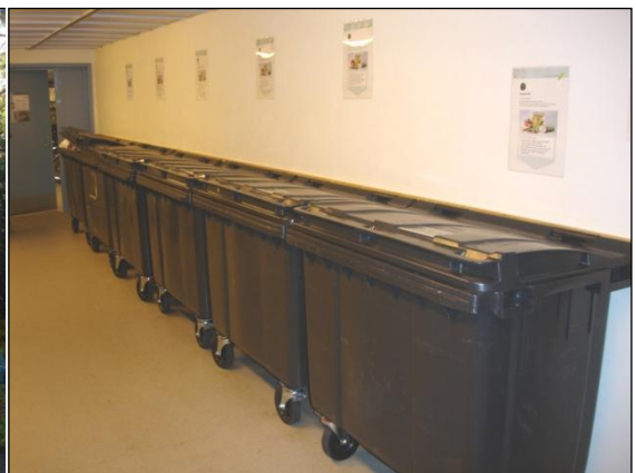
Avfallsrom – foto: Mepex Consult
