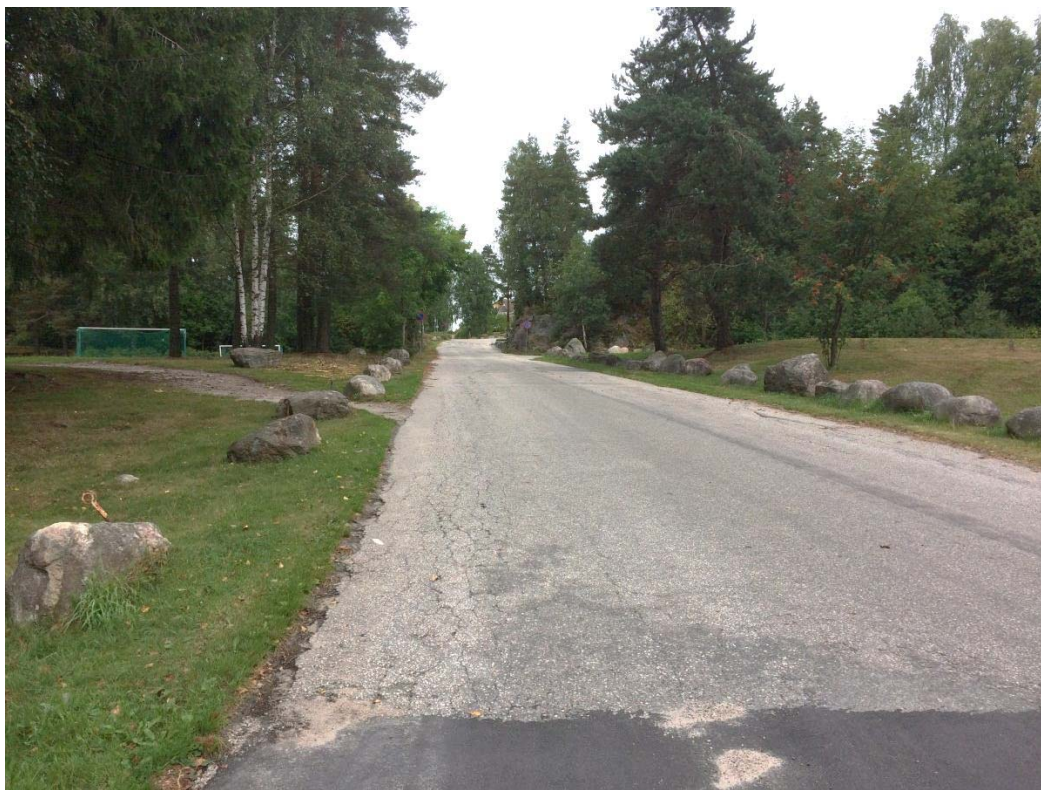
Bilde: Brandheivegen hvor det planlegges fortau fra kryss med Skolevegen til videregående skole
