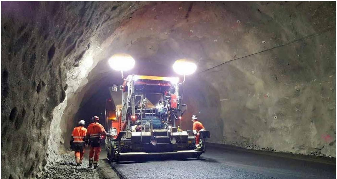
Rykande fersk asfalt vert lagt i Vangbergstunnelen. Mykje arbeid står likevel att før tunnelen kan opnast for trafikk, til dømes lys, ventilasjon og sikkerhetsutstyr.
