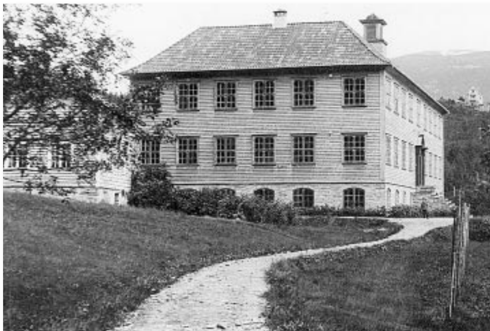
Det nye gymnasbygget i 1924. Vaktmeisterbustaden til venstre. Foto: Per Sande
