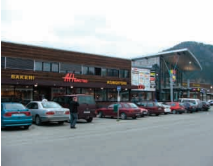
- Det er ikke trygt å være fotgjenger utenfor inngangen til Storsenteret.
