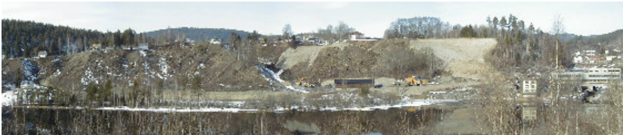
Kongshaugområdet, rassikring etter raset høsten 2000
