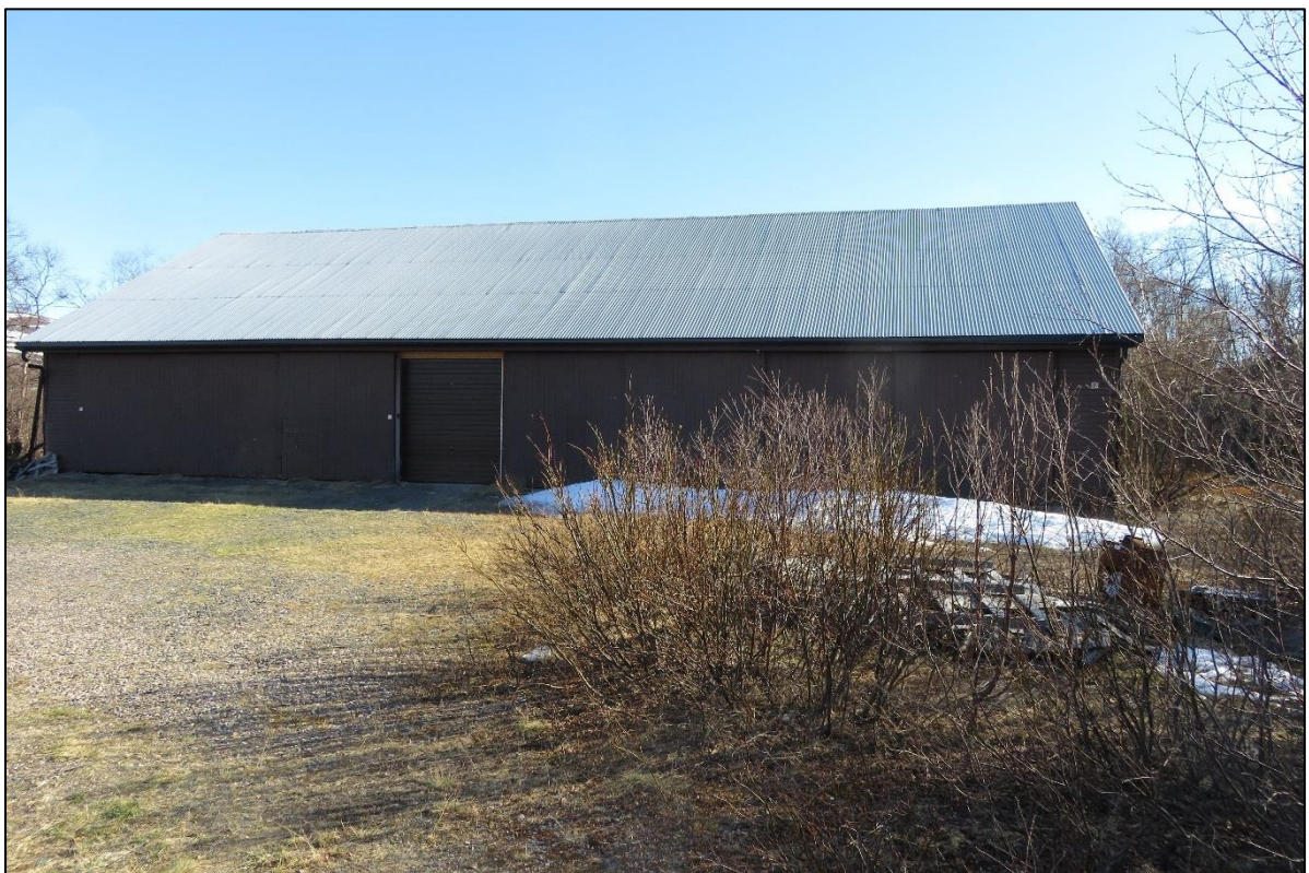
Figur 7 Politiets lageranlegg. Foto: Rambøll/RU
