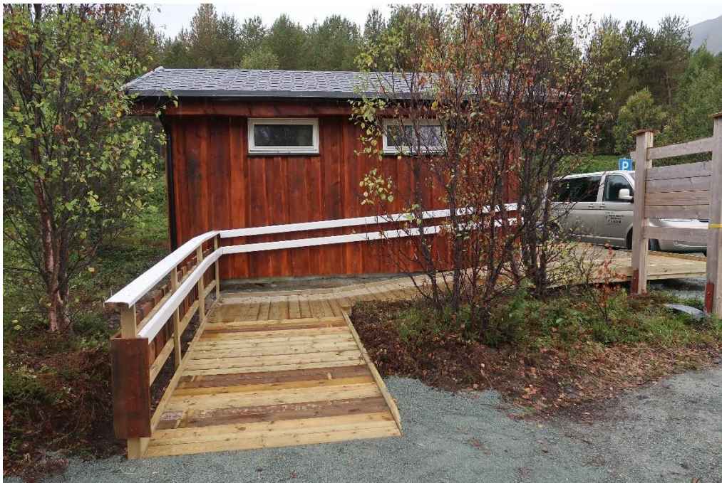
Rampen til toalettet går rundt toalettuset for å oppfylle kravene til helning og snuradier på viloplan. Bilde fra september 2019. Foto: Maja Sjöskog Kvalvik, Ishavskysten friluftsråd
