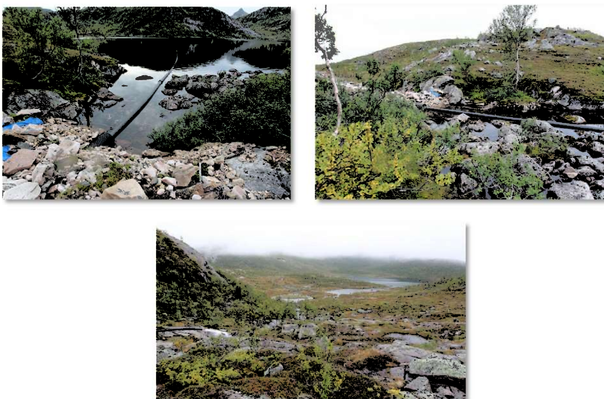
Figur 1. Hevert fra Langvatn og til utløpselva som renner ned i Storelvvatn. Nederste bilde viser utløpet av hevert-ledningen i fossestryket.
