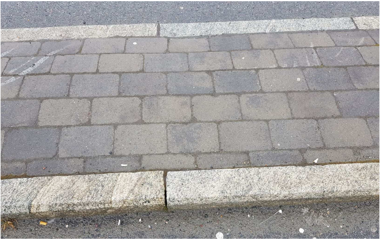
Bilde 9: Kantsteinene og belegningssteinene som er benyttet i eksisterende sentrum, mai 2019.
