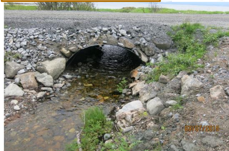
Fig. 70. I elv fra Skatvikvatnet er det anlagt en hvelvkulvert, et rør uten bunn. Den naturlige elvebunnen er bevart og det er gode vandringsforhold for fisk gjennom hvelvkulverten (Foto: Lars Aage Gade-Sørensen).
