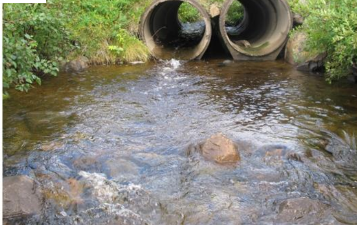
Fig. 69. To betongrør som ligger høyt i fyllingen og utgjør et betydelig vandringshinder for fisk. Vannstrømmen i erodert bort støttemasser under kulvertene (Foto: Øyvind Haugland).
