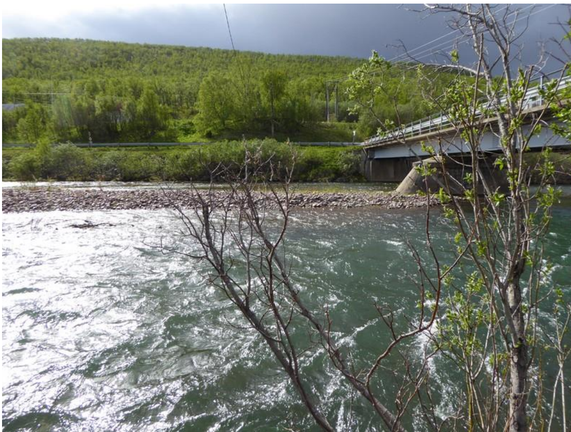
Figur 4 – Juovlajohka/Julelva og Leirpollskogen bru. Sett mot vest. Foto: Statens vegvesen, E. Haagensen
