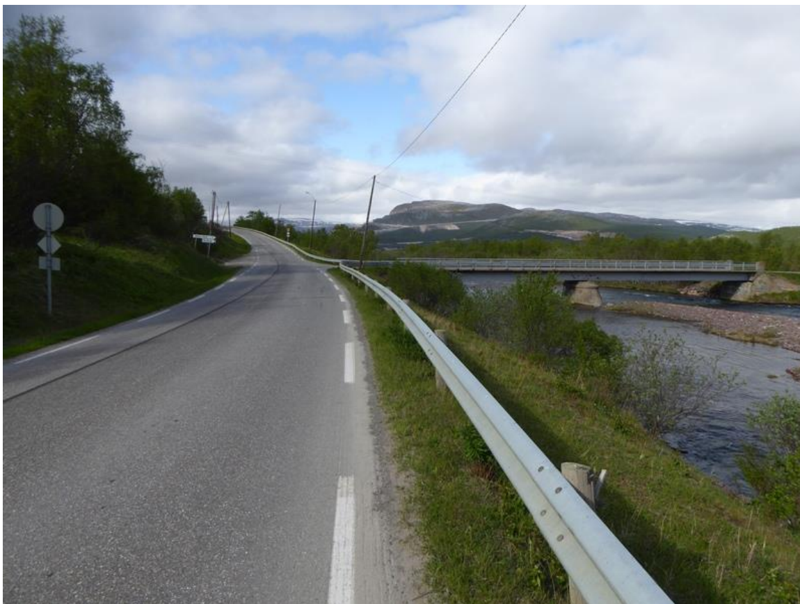
Figur 3 – Fv. 890 og Leirpollskogen bru. Sett mot nord. Foto: Statens vegvesen, E. Haagensen
