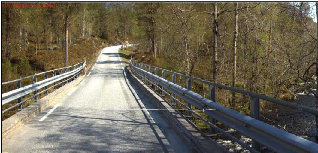
Figur 5.8: Bru i botn av Demmebakkane (Demmebrua)
