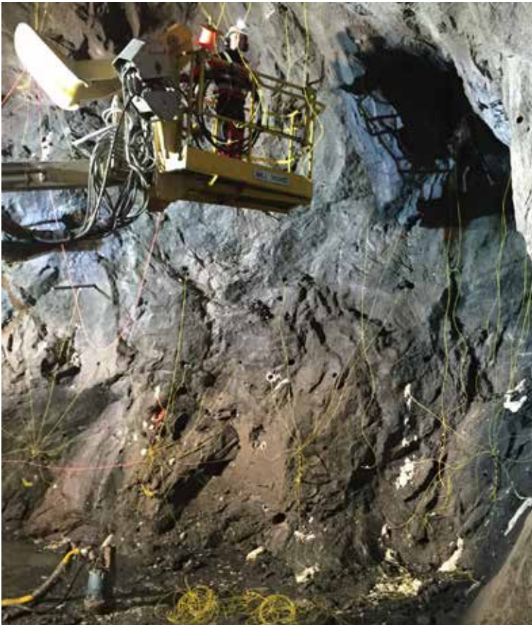
Lading av salve for sprenging av teknisk nisje. Foto: Svein Rune Vie, Statens vegvesen.
