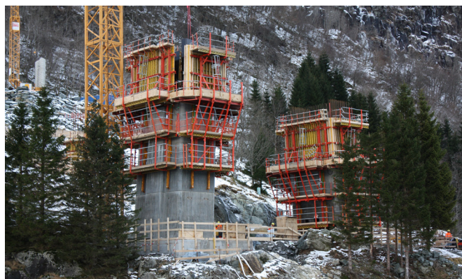
I 2011 byrja arbeidet med byggjinga av brufundament på Dalsfjordbrua. Foto: Ole Ingar Hagen Hæreid/Sogn og Fjordane fylkeskommune.
