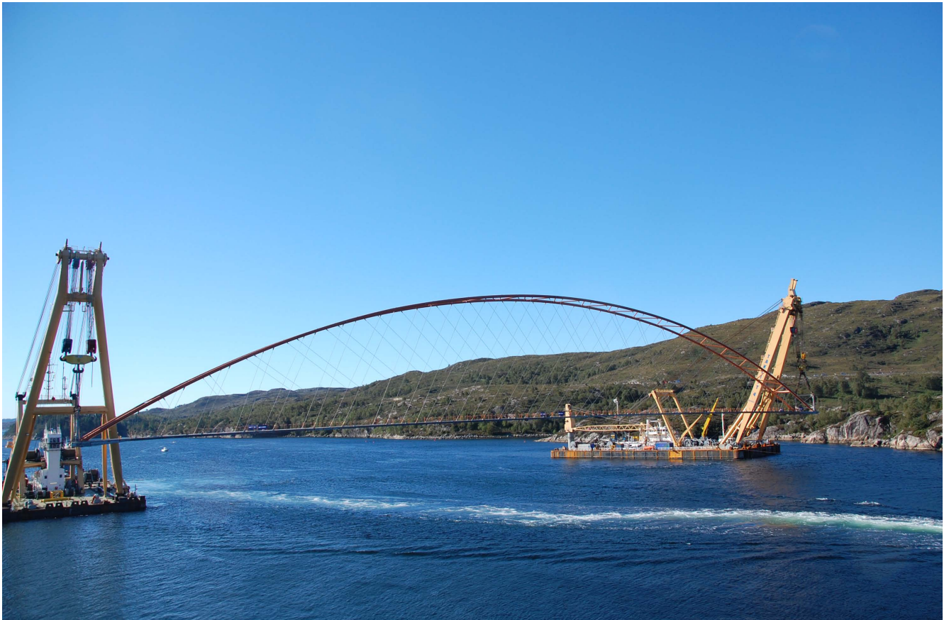
Brandagersundbrua, ein del av fv. 4 Sløvåg-Ånneland, blir her frakta mot sundet mellom Fivelstad og Sandøy der ho blei montert. Hovudspennet til brua som er ei nettverksbogebru på 220m, blei bygd i Sløvåg. Foto: Aril Hanekamhaug/Statens vegvesen.
