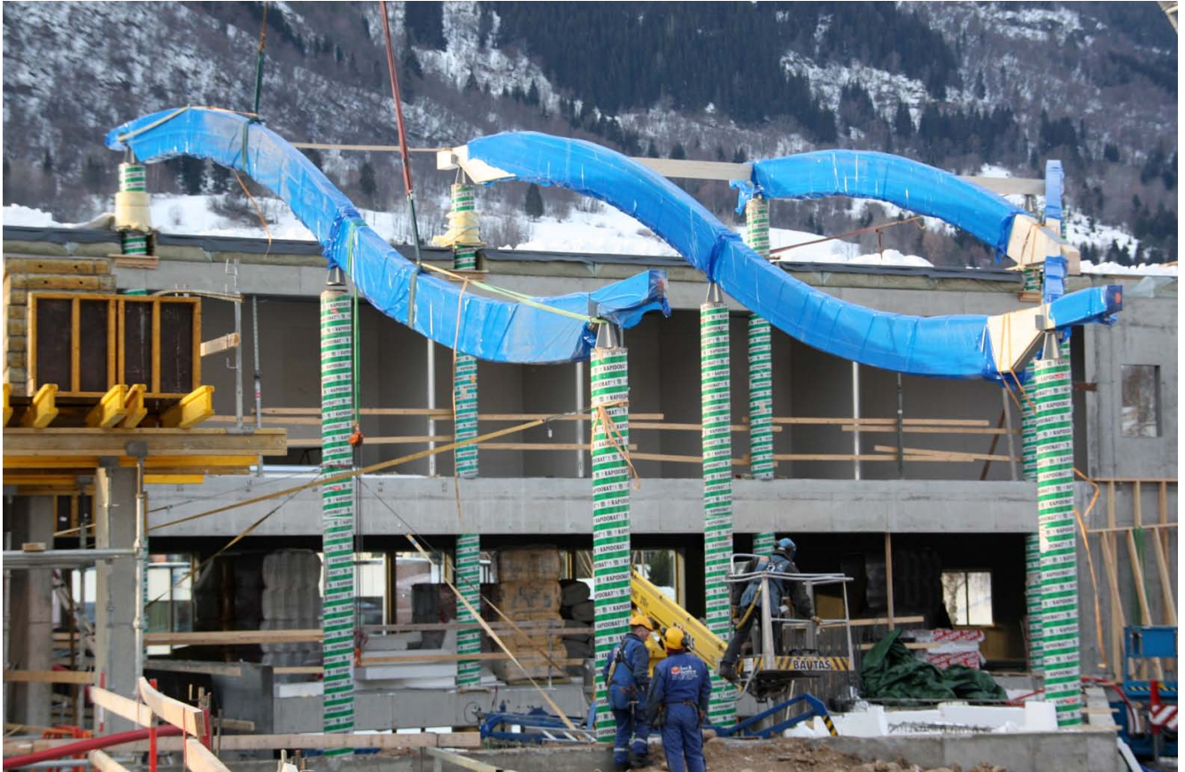
Nye Sogndal vidaregåande skule på Fosshaugane Campus, byggetrinn I. Slik såg byggeplassen ut 19. februar 2010.
