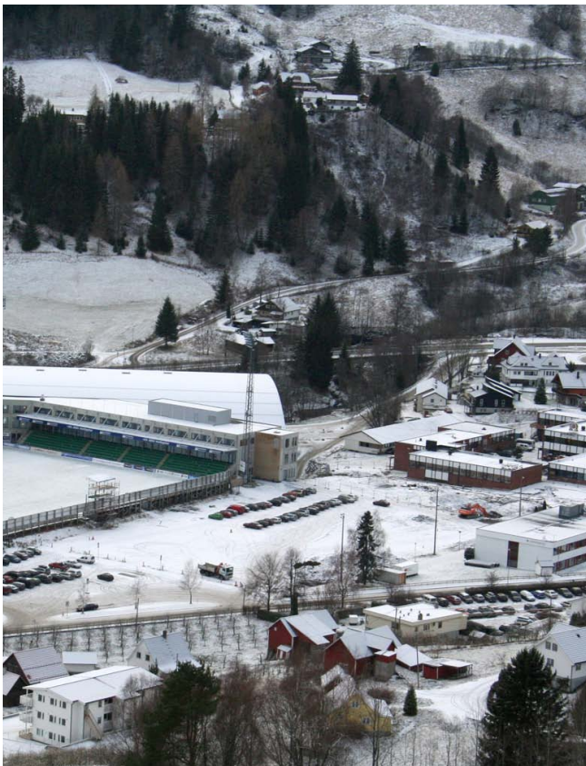
Før byggjstart, med grusbana midt i bilete. (desember 2008).
