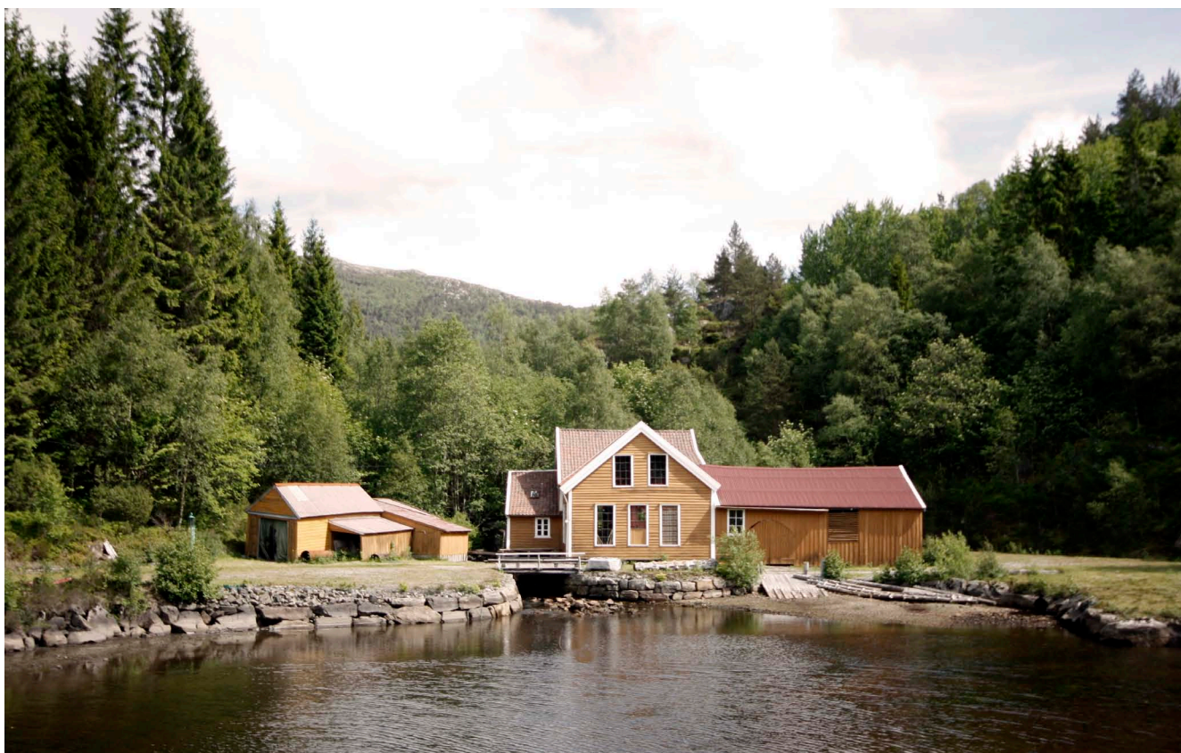
Forslag om freding av Sellevåg treskofabrikk i Gulen vart ferdigstilt og sendt Riksantikvaren for vedtak i 2010. Foto: Arlen Synnøve Bidne/Sogn og Fjordane fylkeskommune.
