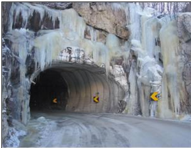
Bilete 1 og 2: To døme på manglande portal-, vass- og frostsikring, fv. 53 Jåteli (foto: David Håndlykken).
