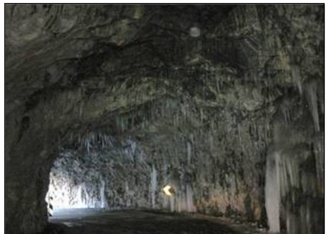
Bilete 1 og 2: To døme på manglande portal-, vass- og frostsikring, fv. 53 Jåteli (foto: David Håndlykken).
