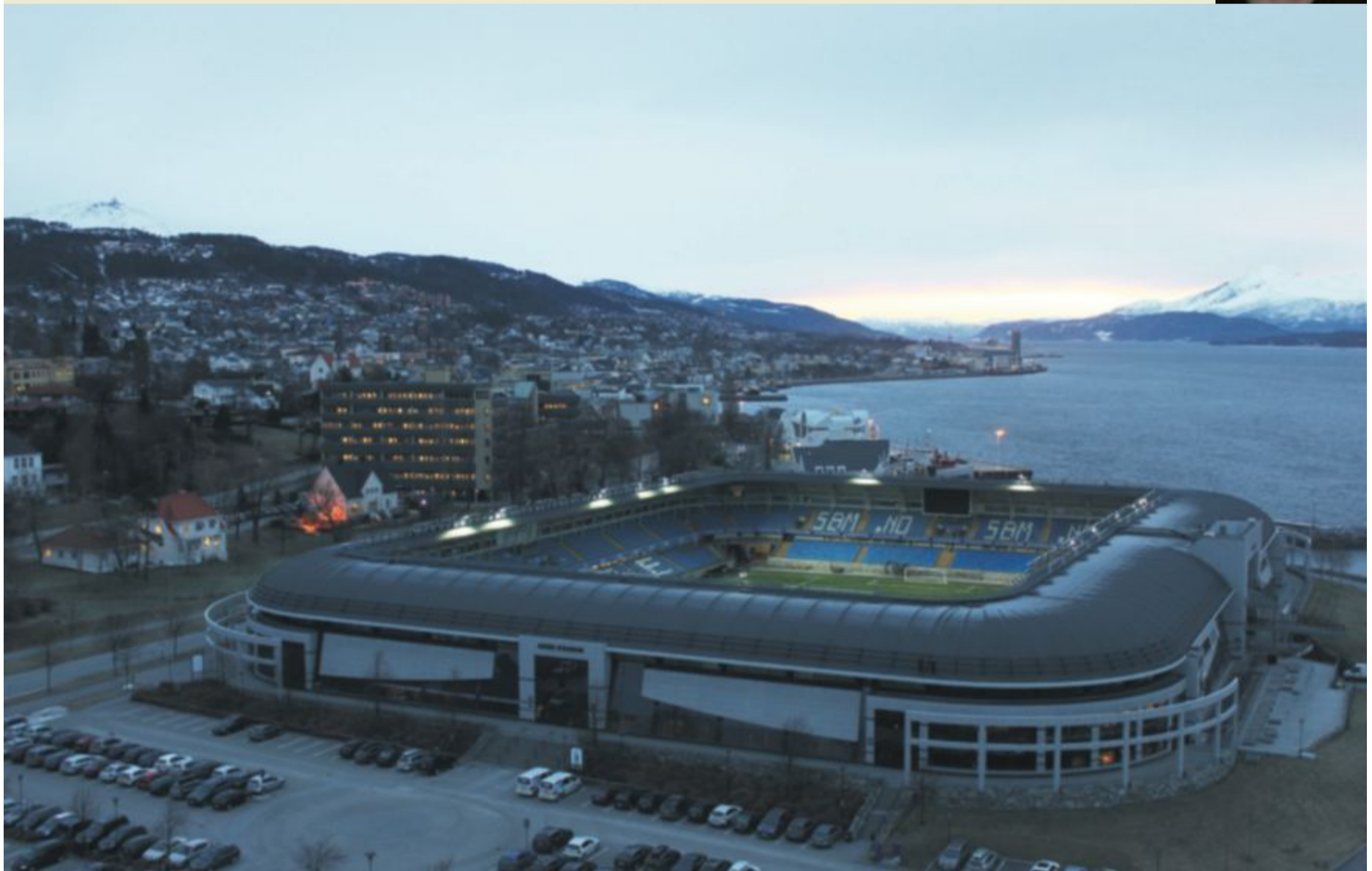
Molde blir kalla «panoramabyen» med rette. Synsrande med dei mange fjella er godt synleg frå Rica Seilet. Rett ved ligg Kjell Inge Røkkes gåve til byen, Molde stadion.
