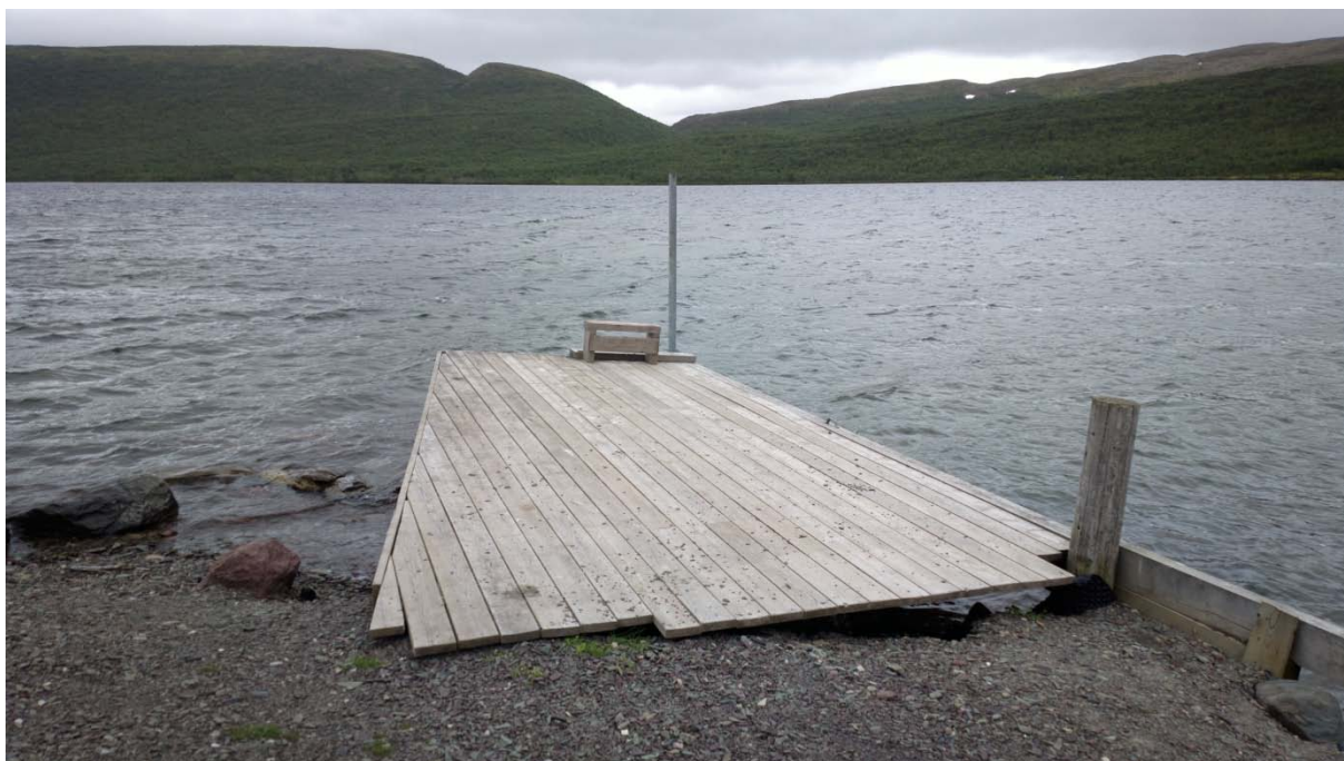
Foto: Brygge/kaianlegg. Foto: Frans Eriksen 19.07.2012.
