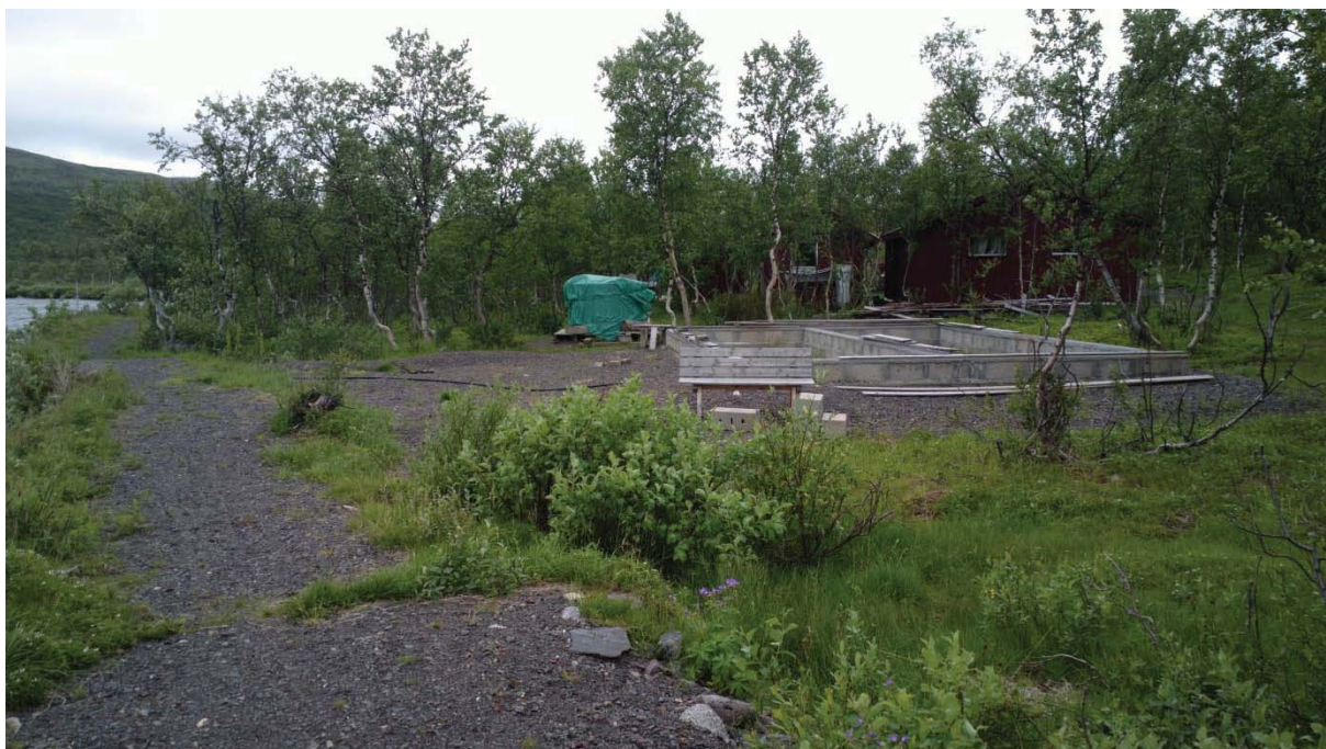
Foto: Påbegynt sanitæranlegg/spaavdelig og utendørs badestamp på baksiden av lagerbyggene. Foto: Frans Eriksen 19.07.2012.
