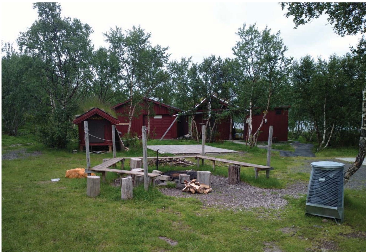
Foto: Vedskjul, lagerbygg, lager/vaktrom og toalett i bakgrunnen. Områdets bål plass i front. Foto: Frans Eriksen 19.07.2012.
