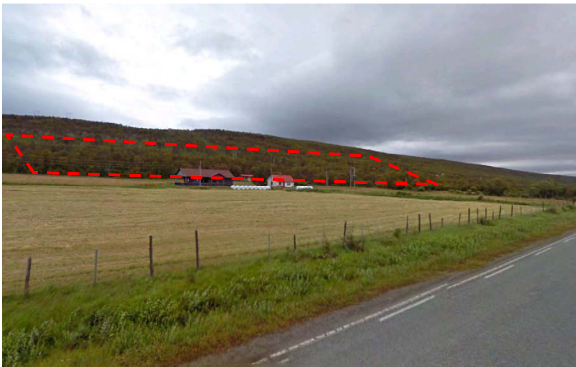
Figur 3: Eiendom 37/66, omtrentlig plassering i skråning (Kilde: Google Earth)
