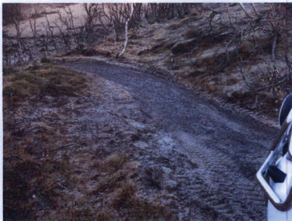
Figur 2 Bildet viser begynnelsen av veien VP 0164.
