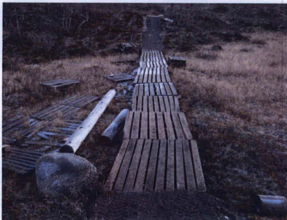
Figur 7 Bildet viser bru som er bygd over myr. Telegrafstolper og paller ligger ved siden av brua.
