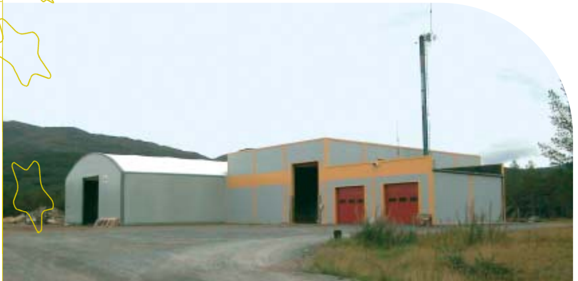
Dyrøy Energi A/S' biobrenselanlegg kan levere ca. 5 millioner Kwh i året til offentlige og private bygg i sentrumsområdet av Dyrøy kommune.
