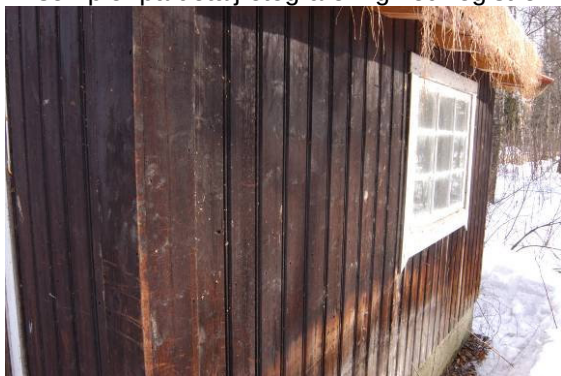
Panel og vindu, hønehus.
