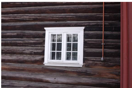
Vindu mot øst i Dalseggstua.
