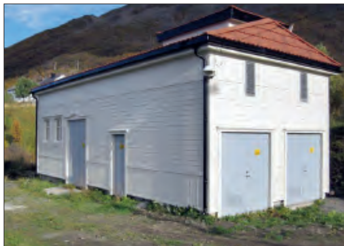
Renovert fasade, Bergsfjord kraftverk.
