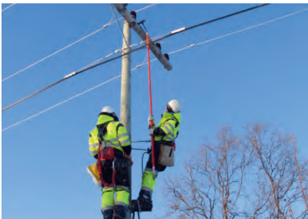
Toppbefaring 22kV opplæring AUS. Å jobbe AUS (arbeid under spenning) har vært et fokusområde i 2009, og det medfører færre planlagte utkoblinger på strømmettet. Dette vil også være et satsningsområde i 2010.
